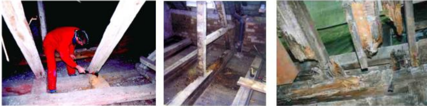
Slika br. 112 Najjednostavnija metoda za detekciju oštećenja je metoda "na pogled" sa otvaranjem stropnih konstrukcija i neposrednim označavanjem [13]
